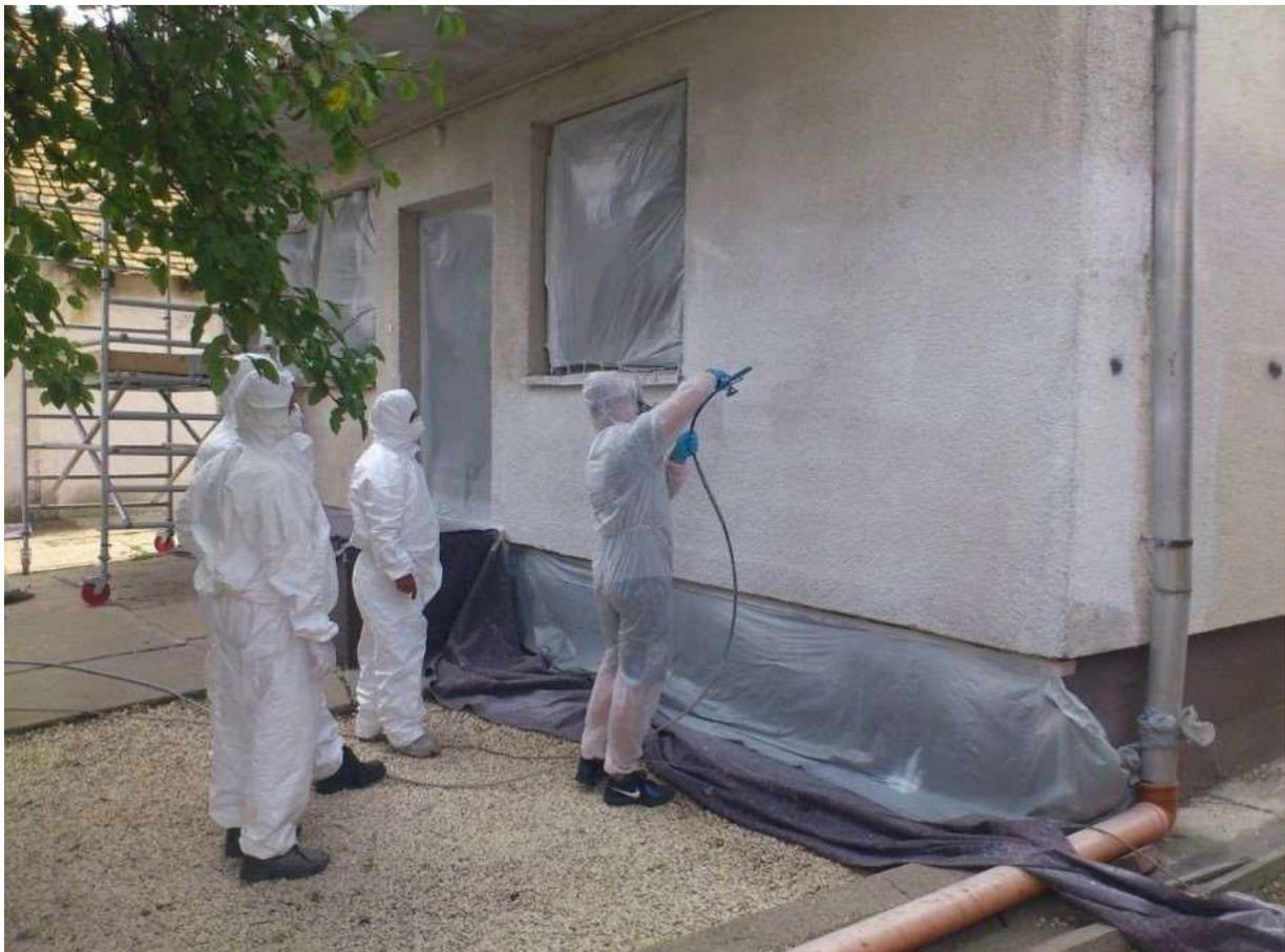
Achten Sie beim Spritzen immer darauf, dass die Spritzpistole senkrecht zur zu besprühenden Oberfläche gehalten wird, und zwar in dem durch die Düse definierten Abstand, und dass die Spritzlackieranlage den Betriebsdruck und das Spritzprofil ungestört beibehält, da nur so ein einwandfreies Spritzbild erzielt werden kann. Der Sprühradius muss gleichmäßig sein. Wenn Streifen im Sprühstrahl erscheinen, ist der Sprühdruck zu niedrig. In diesem Fall sollte der Druck erhöht werden.
