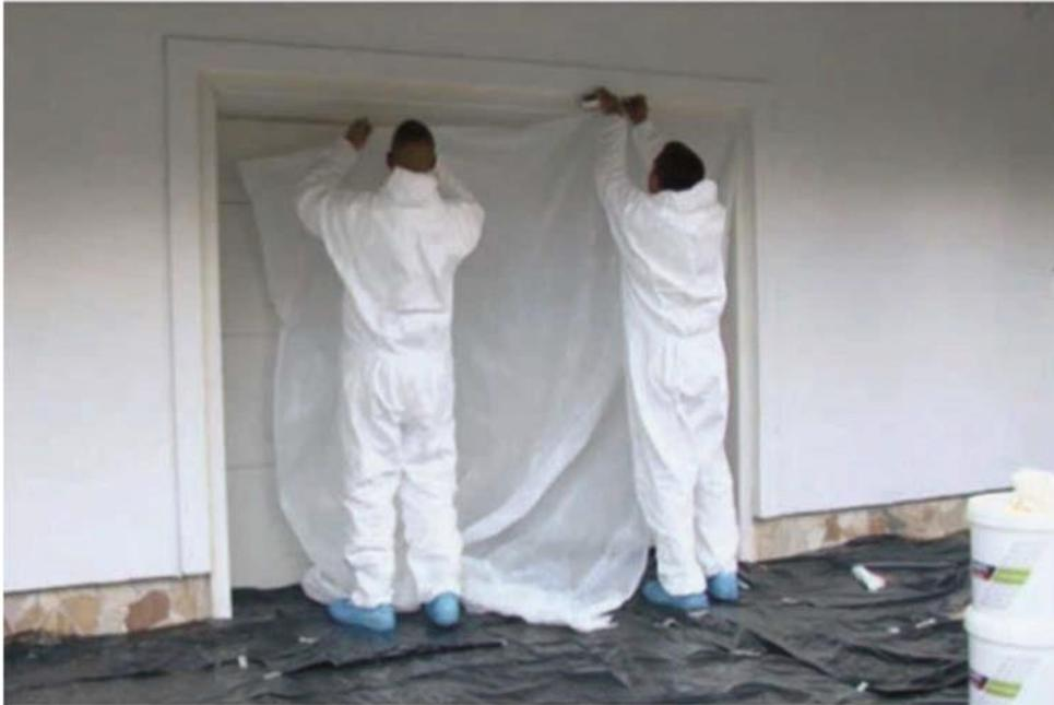
Je nachdem, ob Sie von einer Leiter oder einem Gerüst aus arbeiten, benutzen Sie in einem angemessenen Abstand eine Abdeckfolie, um zu verhindern, dass bei der Ausbesserung der Wandoberfläche und der Beschichtung Schmutz auf den Boden gelangt.
