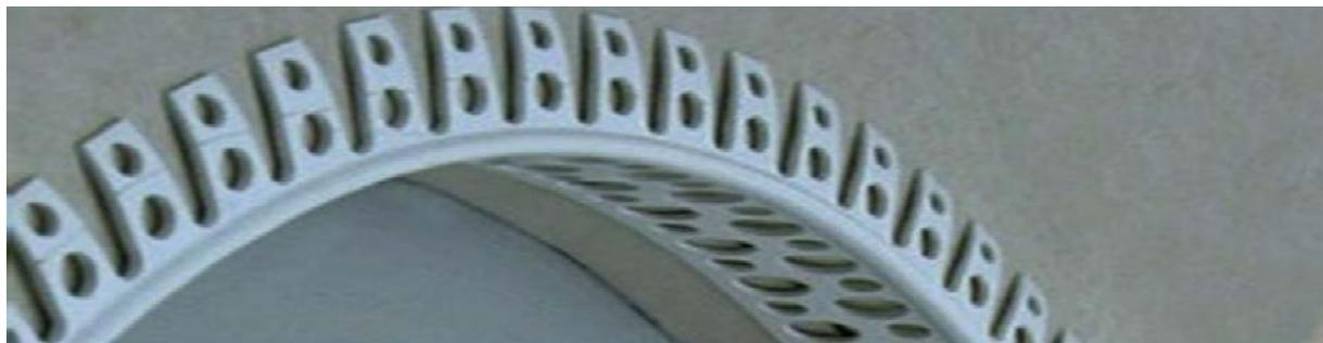
Die Kanten gebogener Gipskartonplatten können durch den Einbau von biegsamen Kantenschützern zu bruchsicheren Kanten gemacht werden.
